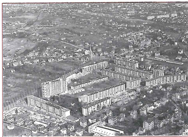
Vue aérienne de la résidence des Bas Coudrais en 1957 / I.G.N.
