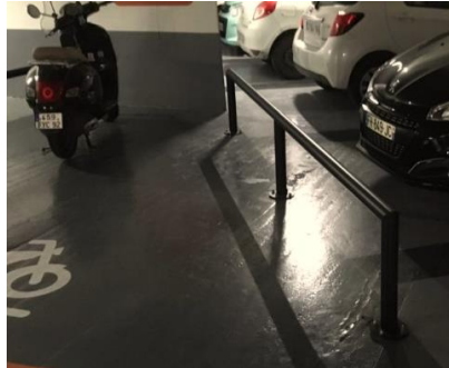
Remis en état fixation des arceaux à Robinson
