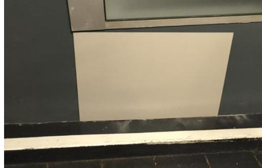
Remis en état du mur en posant une plaque
